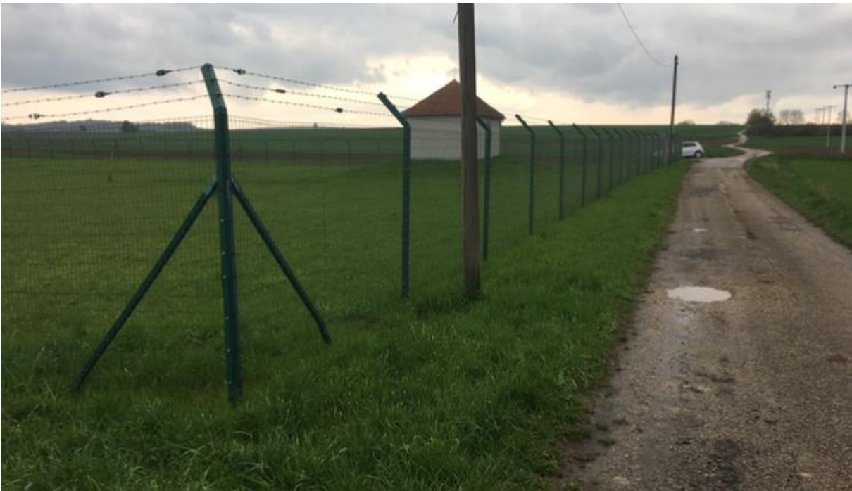
Abbildung 3: In Blickrichtung Buxheim ist auf dem Foto die Umzäunung der engeren Schutzzone II, das Gebäude des Brunnen 1, sowie die Zuwegung von der Moosmühle zur Wolkertshofener Straße (EI 5) zu sehen.
