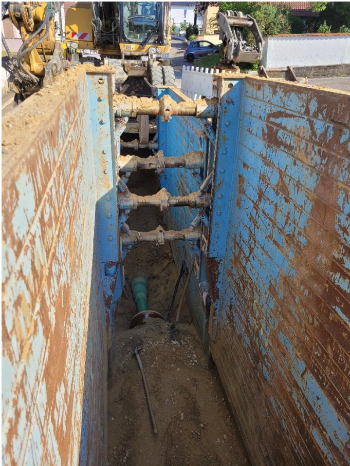
Bild: Kanalbau in der Volchlinstraße
