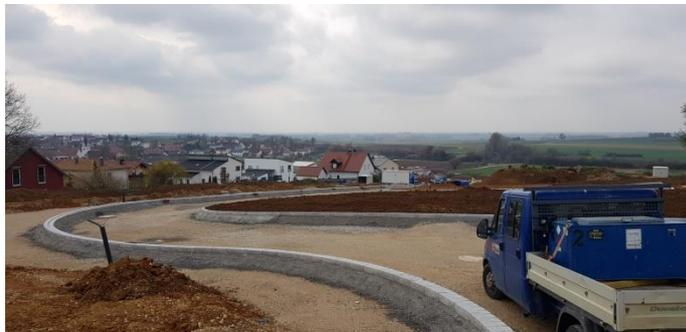
Die ersten Ergebnisse lassen sich schon feststellen, von Nord nach Süd werden bereits die Einfassungen für die Fahrbahn gesetzt.
